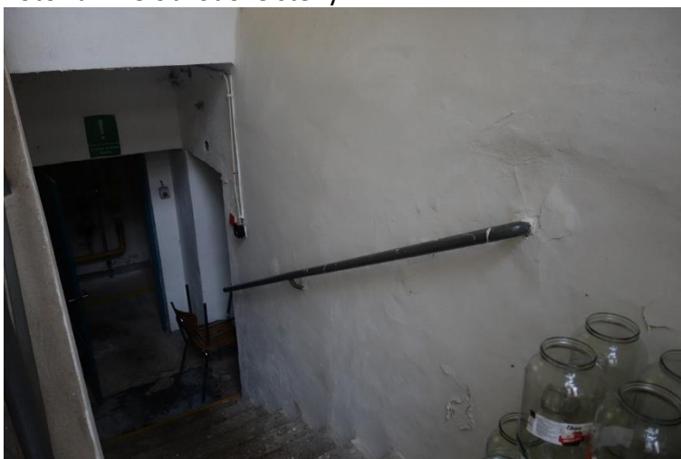
Pohled na zavhlou schodišťovou stěnu do sklepa
